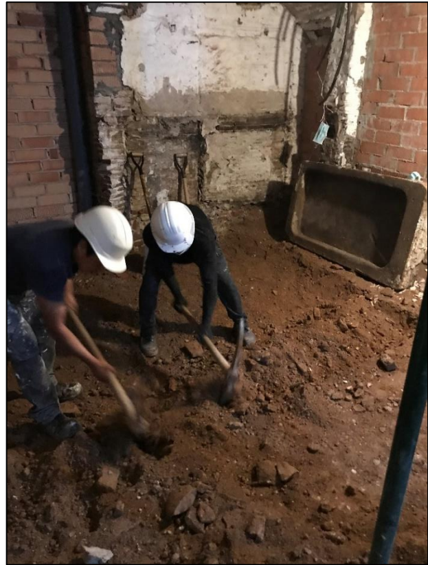
Figura 8. L'excavació s'ha fet íntegrament amb mitjans manuals
