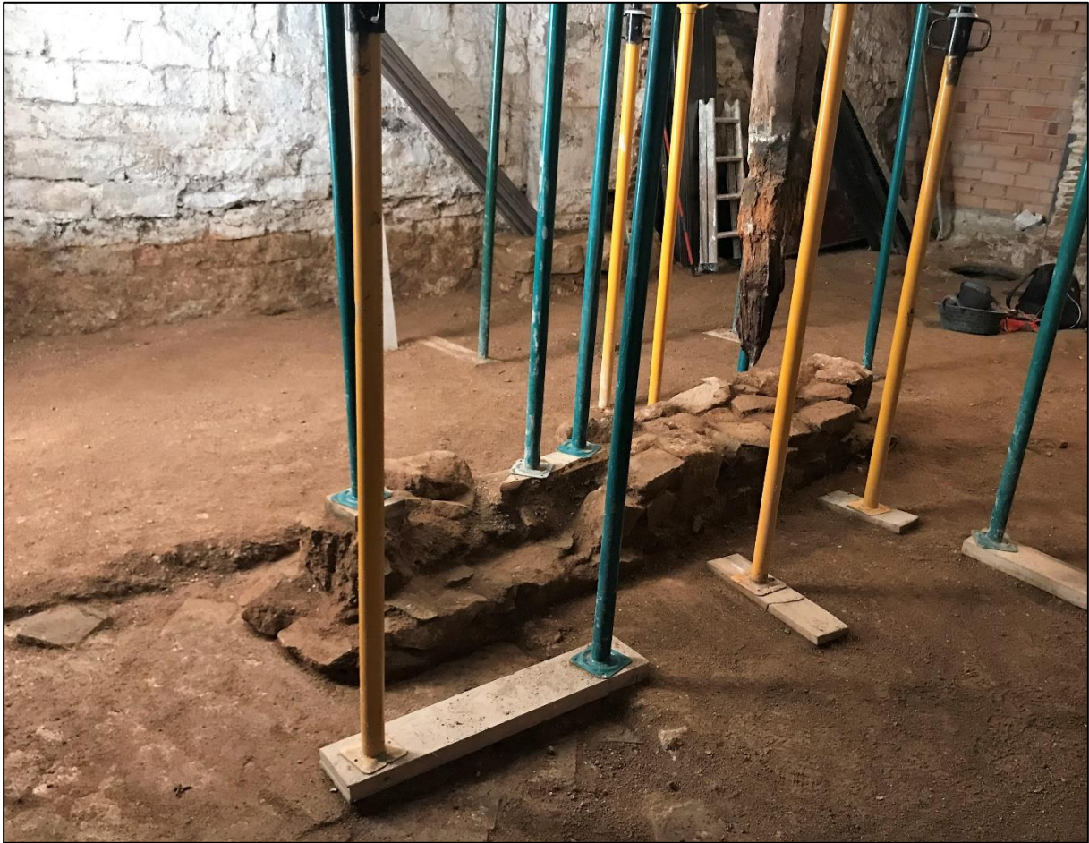
Figura 16. Aspecte de l'estança un cop finalitzada la intervenció
